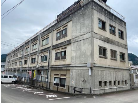
<本庁舎（本館）南側>
