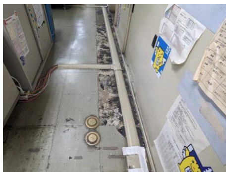
<本庁舎（本館）執務室床>
