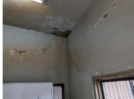
<本庁舎（本館）廊下>
