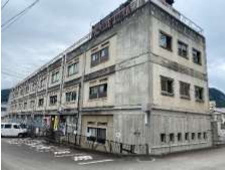
<本庁舎本館 南側>
