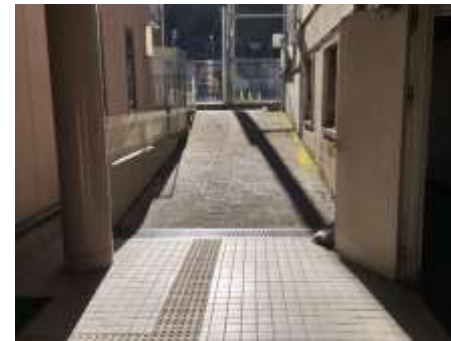
<南側スロープ>
