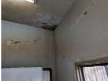
<本庁舎本館 廊下>
