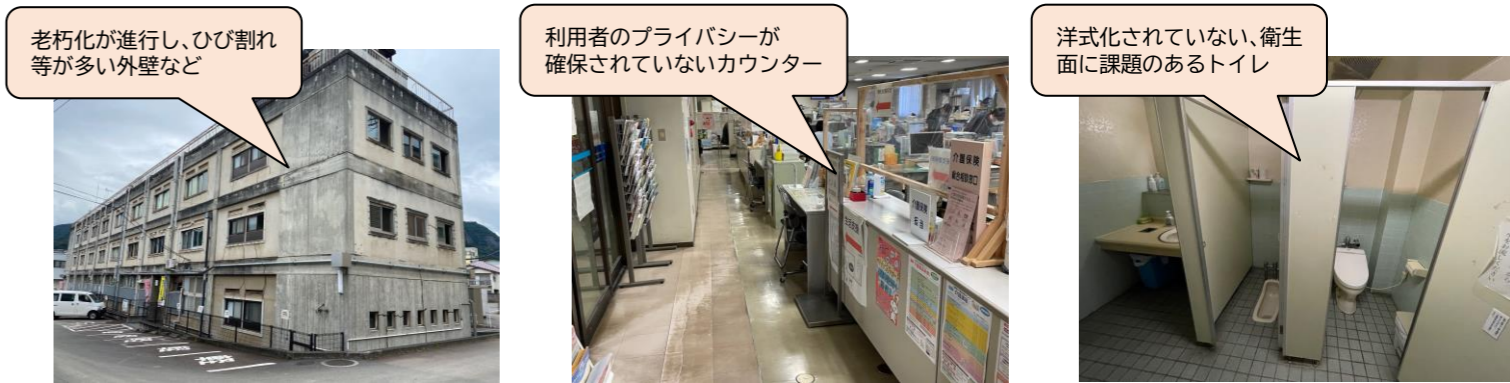
<本庁舎(本館)南側>
