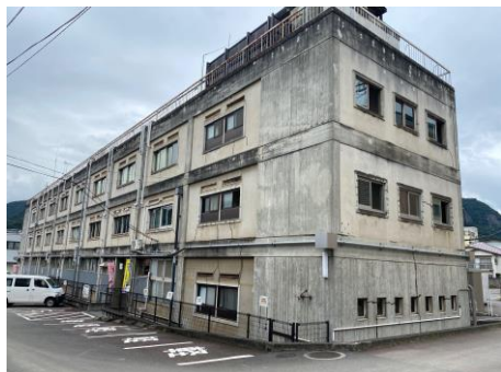
<本庁舎（本館）南側>
