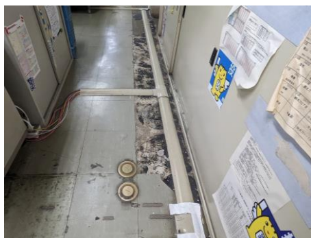
<本庁舎（本館）執務室床>
