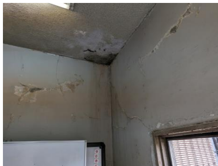
<本庁舎（本館）廊下>
