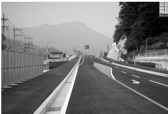
国道 20 号大月バイパス
