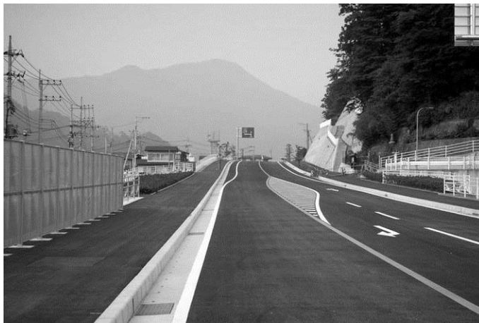
国道 20 号大月バイパス
