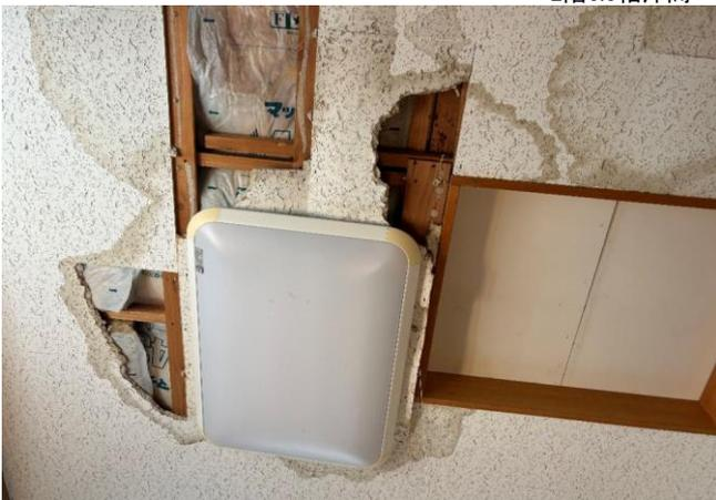
2階7帖洋間天井の雨漏り痕および天井材の欠損
