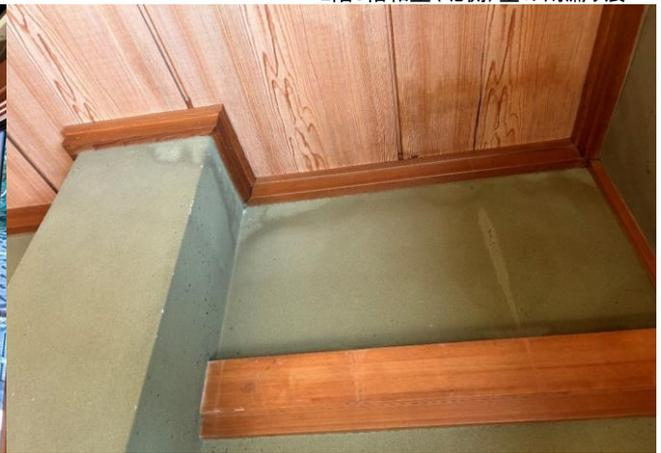
2階6帖和室(南側)天井および壁の雨漏り痕
