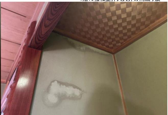
1階10帖和室床の間壁の雨漏り痕
