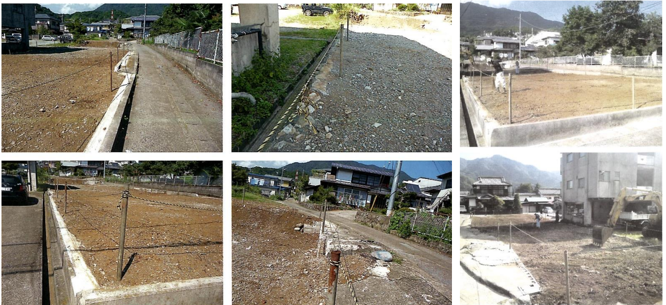
家屋解体工事時(平成25年9月頃)
