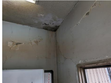
<本庁舎（本館）廊下>
