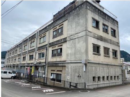
<本庁舎（本館）南側>
