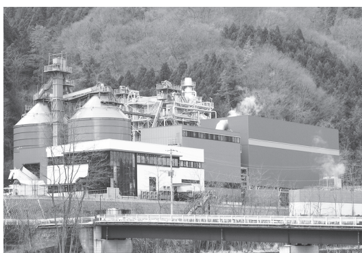
大月バイオマス発電所
