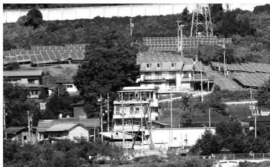
鳥沢地内の太陽光発電設備
