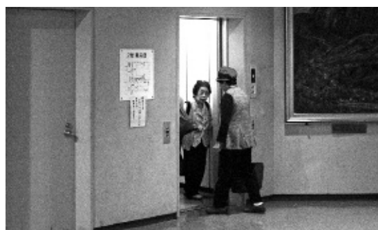
市民会館内のエレベーター
