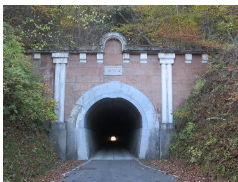
旧笹子トンネル
