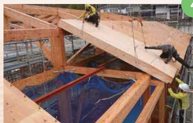
屋根地下の一部 (LVL ボックス) は県産材の唐松
