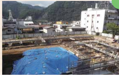
平成 28 年 6 月、N 号館・高校跡地に建設開始
