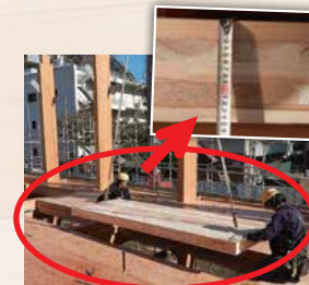
市産材の杉を使った CLT 床パネル
