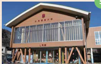
正面玄関や外壁の施工
