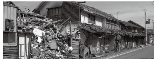
⑤被害を受けた多くの住宅
