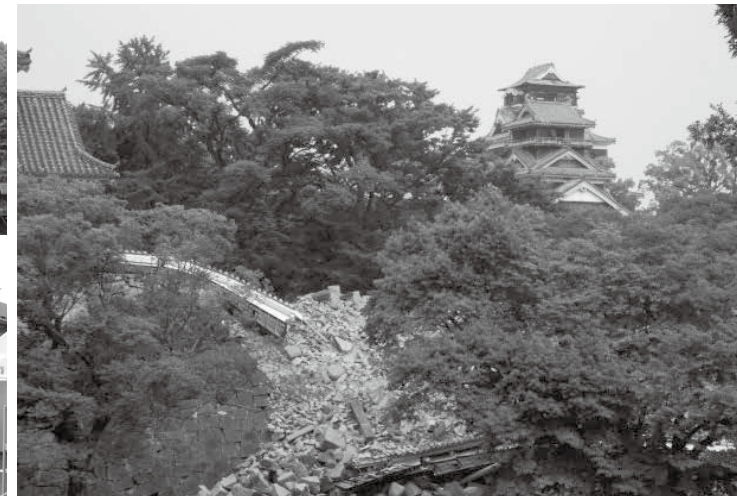
①崩落した熊本城の石垣
