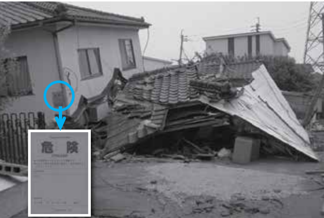
⑨危険判定を受けた倒壊住宅
