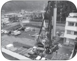
建設工事が進む市立中央病院
