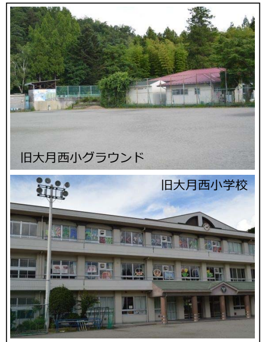
写真-3 廃校小学校の現状
