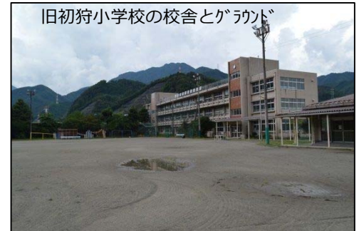
写真-3 廃校小学校の現状
