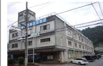
大月市役所：築 56 年【耐震補強未実施】
