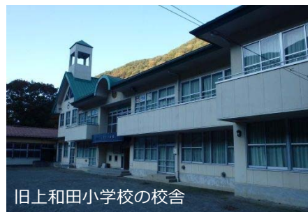
写真-4 廃校小学校の現状
