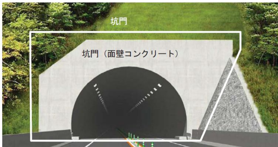
図-3.3 点検対象箇所（トンネル坑口部）
