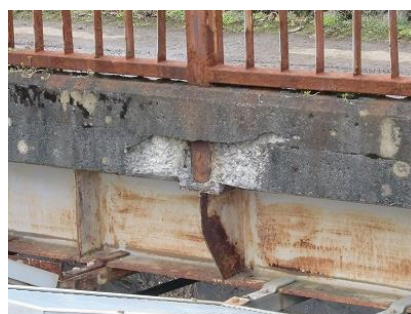
地覆：剥離・鉄筋露出
