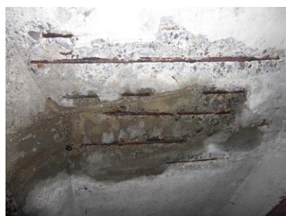
床版：剥離・鉄筋露出
