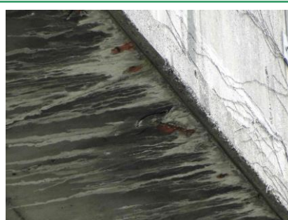
床版：漏水・遊離石灰
