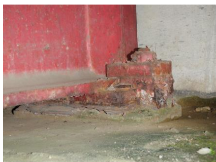
支承：防食機能の劣化，腐食
