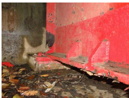
主桁：腐食，変形・欠損
