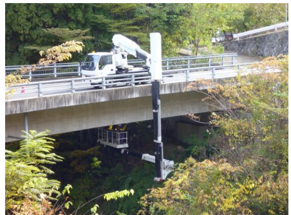
写真-3.2 橋梁点検状況 2
