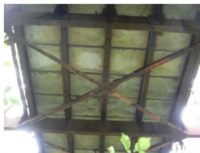
主桁：防食機能の劣化，腐食
