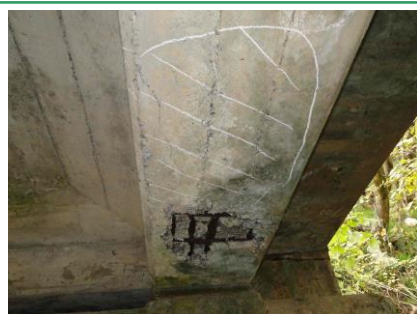
主桁：剥離・鉄筋露出，うき
