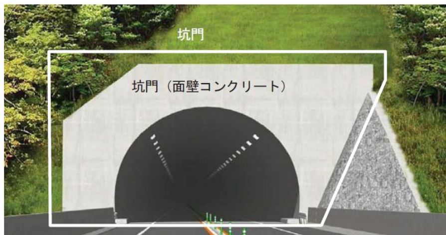
図-3.3 点検対象箇所（トンネル坑口部）
