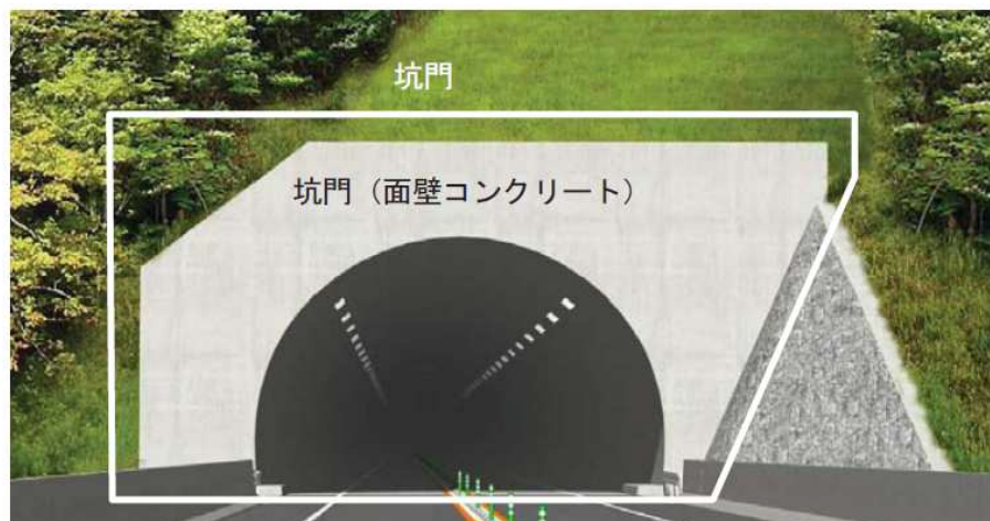
図-3.3 点検対象箇所（トンネル坑口部）
