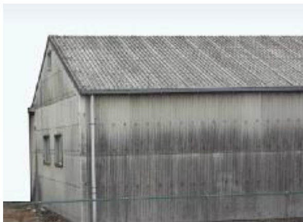
石綿含有スレート波板（屋根・外壁）
