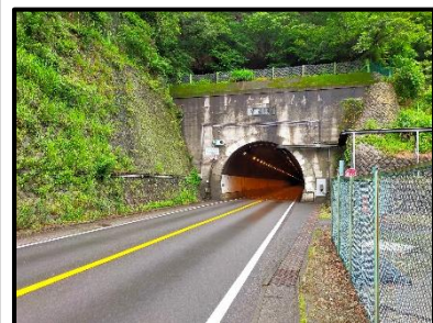
国道20号 新笹子隧道
