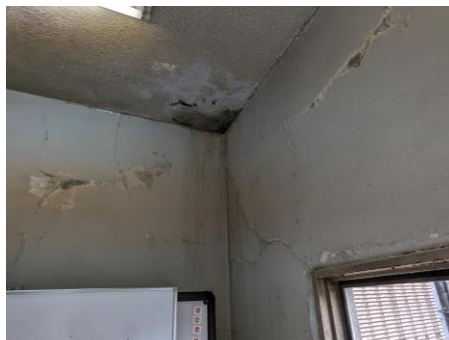
<本庁舎（本館）廊下>
