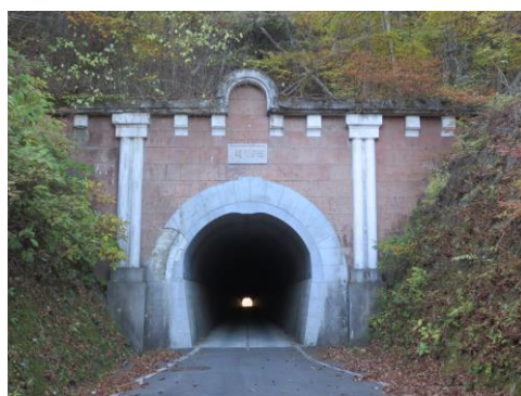
旧笹子トンネル
