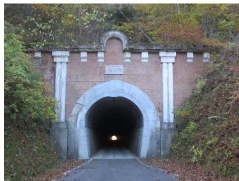
旧笹子トンネル
