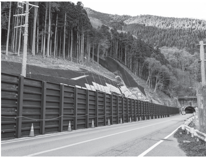
法面工事の様子
