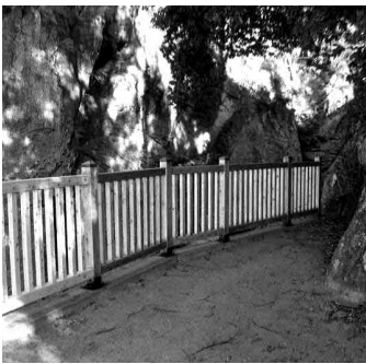
展望台手すり
