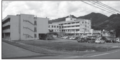
建設工事中の市立中央病院
