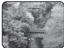
八ツ沢発電所の水路橋
